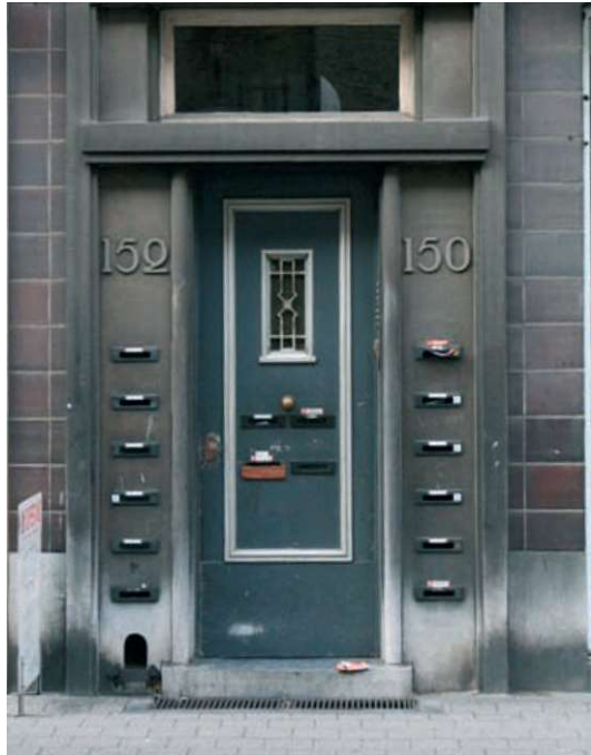
Inkomdeuren worden gerenoveerd
