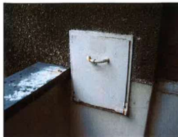
Fig. 146. IJzeren klep met handvat op het terras
