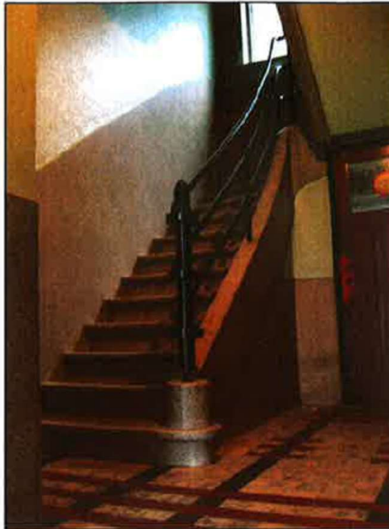
Fig. 129. Traphal op de gelijkvloerse verdieping (kleine woonblok): trap in granito en cementtegelvloer
