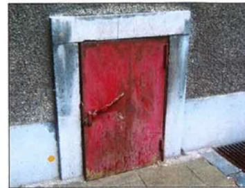
Fig. 147. Vuilschuif op de begane grond
