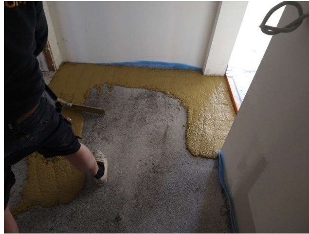
2) Stort terrazzobeton op epoxy primer
