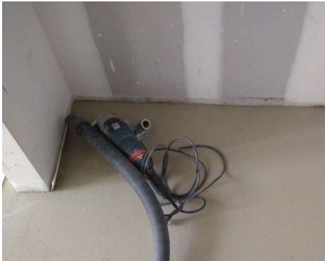
4) Start schuurwerken, => onder het stof verschijnt de terrazzobetonvloer
